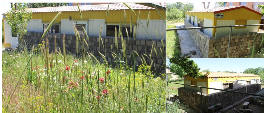
شکل ۶۴. (رنگی در نسخه الکترونیکی) دیوار آجر بتنی در حال ساخت اطراف کانکس. این دیوار در سه طرف کانکس تا سقف تکمیل شد.
